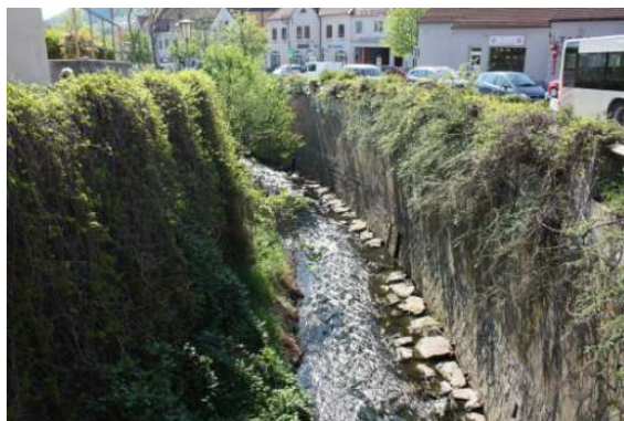
Der Gablitzbach in Purkersdorf
