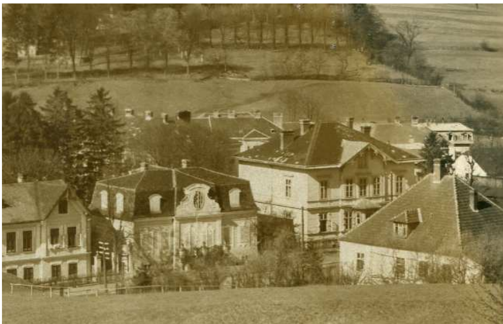
Ein Foto des Hauses Linzerstraße 97 mit Giebeldach (nach 1913). Foto GG
