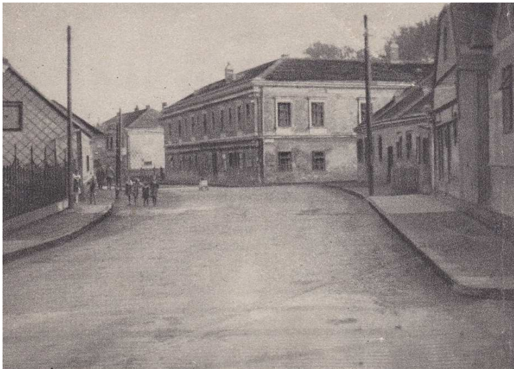
Blick Richtung Osten mit dem Haus Hauptstraße 19, lt. Weiss um 1910, vmtl. nach 1921 (wegen der Lichtmaste).
